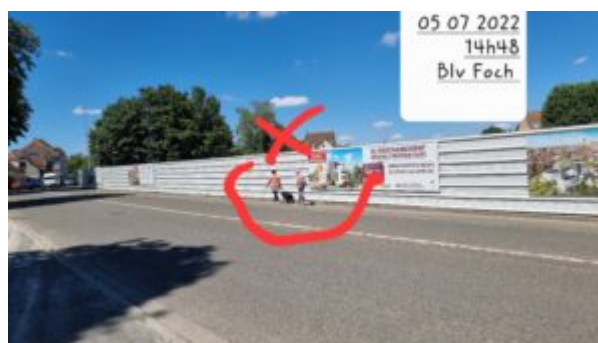
chantier Blv Foch
