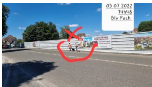
chantier Blv Foch
