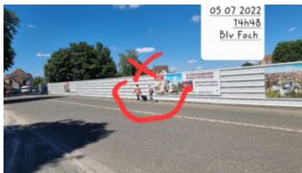
chantier Blv Foch
