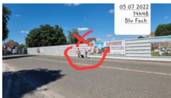
chantier Blv Foch
